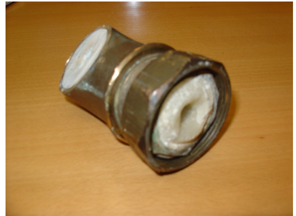
Abbildung 3: Trotz Kalkmagnet: Diese Warmwasserleitung war nach 7 Jahren Betrieb vollständig verkalkt.
